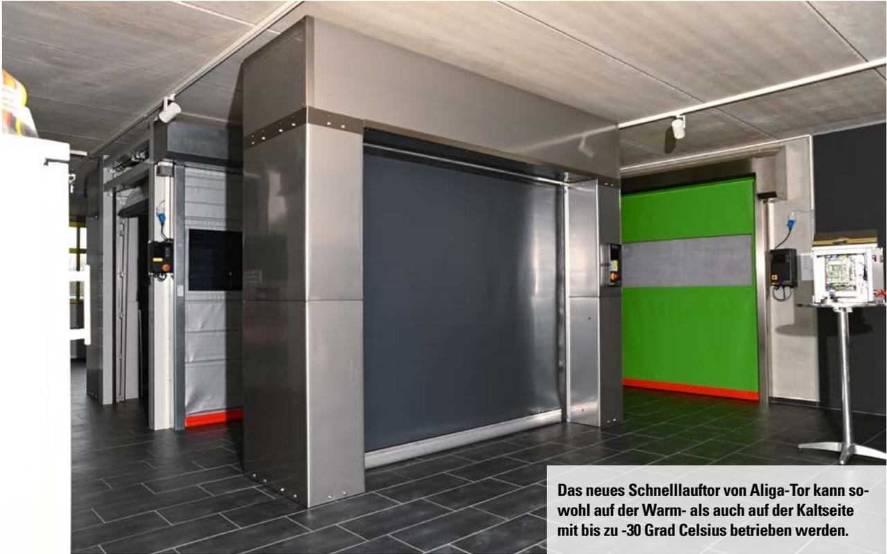
Das neue Schnelllauftor von Aliga-Tor kann sowohl auf der Warm- als auch auf der Kaltseite mit bis zu -30 Grad Celsius betrieben werden.
