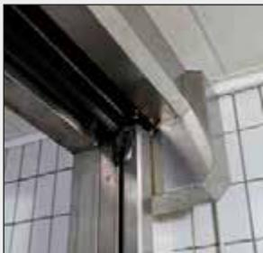
Ein zentraler Punkt des Standards ist die unbeeinträchtigte Möglichkeit zur Reinigung der Oberflächen und konstruktiven Elemente. So wurde auf schräge Oberflächen geachtet, auf denen sich kein Wasser oder Abfälle sammeln können.
